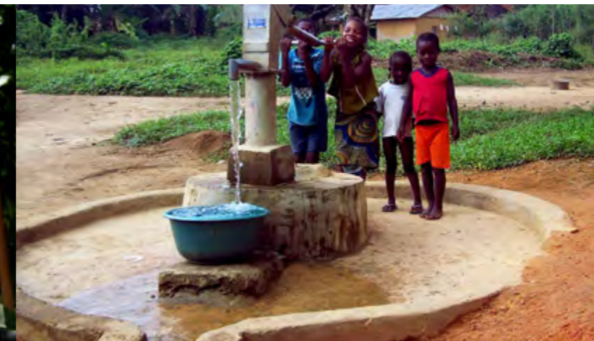
Pompe hydraulique villageoise dans une communauté au Liberia
